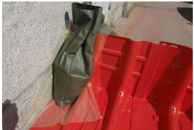
14. ...oder mit Kunststoff-Folie/Plane und Sandsäcken
