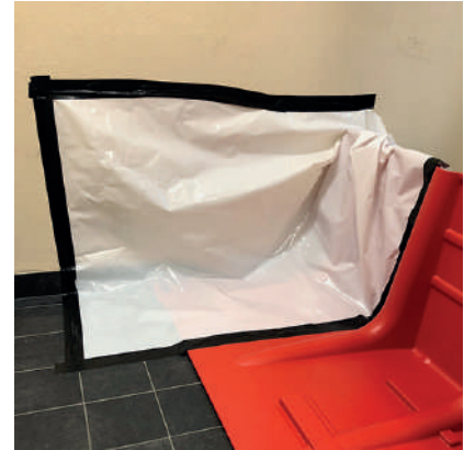
Abdichtung mit einer Folie
