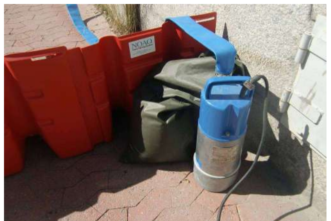
8. Pumpe bereitstellen für allfälliges Leck-Wasser
