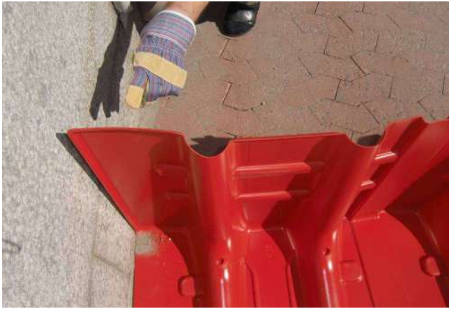
9. Ende des Walles von hinten abstützen...
