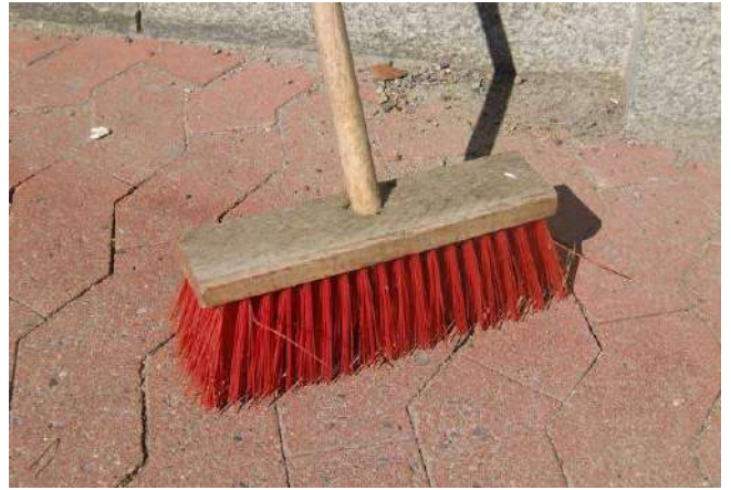
2. Der Untergrund muß eben und sauber sein (frei v. Sand usw.)
