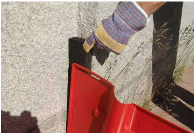
13. Außenverbindung mit Schaumstoff-Streifen abdichten...
